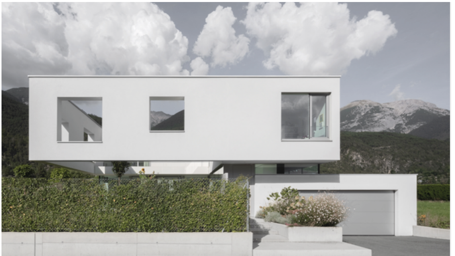
Von außen gesehen verschmelzen der gerahmte Hof und der massive Baukörper zu einer Einheit. Die Garage ist leicht zurückversetzt unter das Obergeschoß geschoben.
